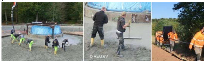
Bild: Betonierung des 1. Fundaments fast fertig / Glättung der Oberfläche / Verlegung Leerrohr westlich der Tennisplätze
